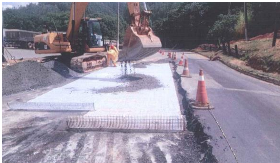
Foto 8 – Reparos no pavimento - Km 133+500 [2]
