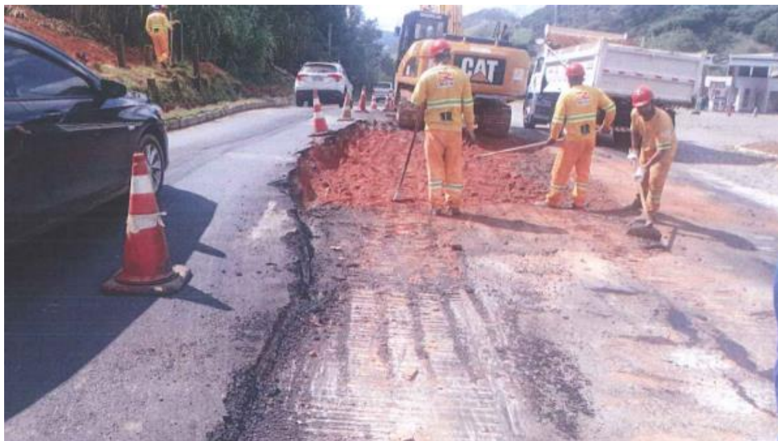
Foto 7 – Reparos no pavimento - Km 133+500 [1]
