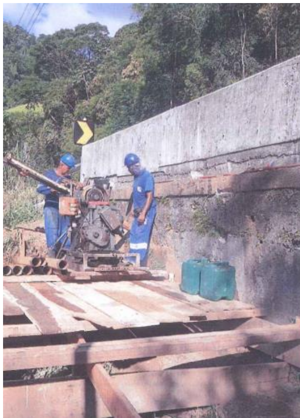
Foto 5 – Reforço no muro de contenção – Km 056+600 S
